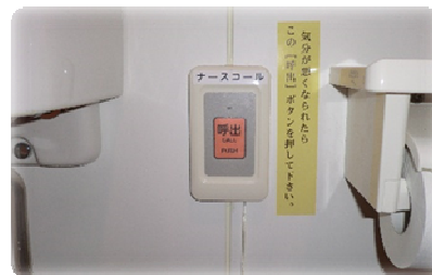
トイレなどの呼び出しボタン
